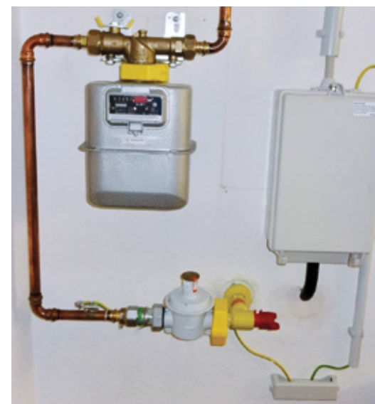
Korrektter Anschluss an die Haupterdungsschiene.
