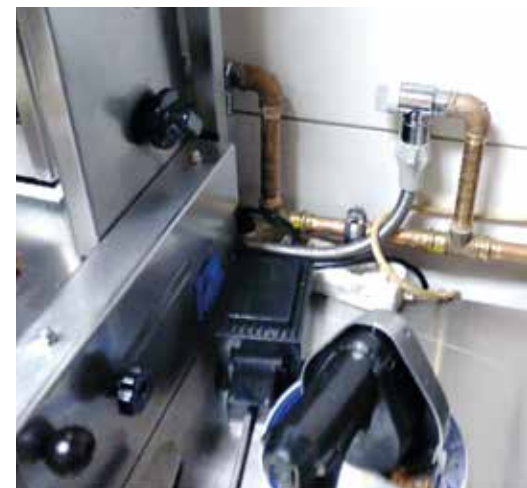
Beispiel für den lösbaren Anschluss eines Gasgerätes.
